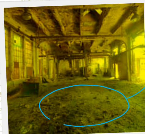
Vecchie ferriere zona stazione
